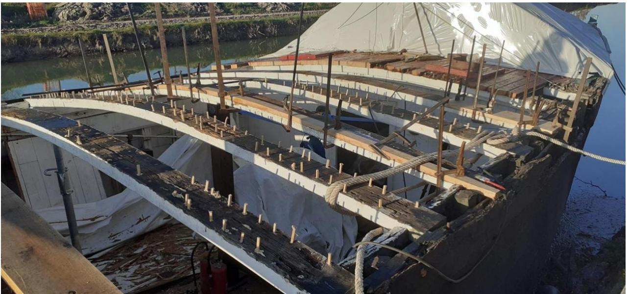
L'épine (pièce centrale arrière) a été débitée, corroyée et chanfreinée. Avec ses 10 mètres de long, ses 350 mm de large et ses 300 kg, cette pièce en chêne nécessite au minimum 4 personnes pour la manutentionner... Impossible aussi de la travailler dans l'atelier car il faut au moins 25 mètres de champs libre pour la passer dans la raboteuse. Nous avons donc dû sortir la machine !
