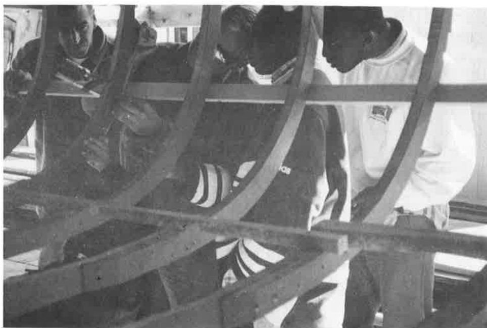
Yole MASSALIA Apprentis charpentiers et formateur (automne 1999)
