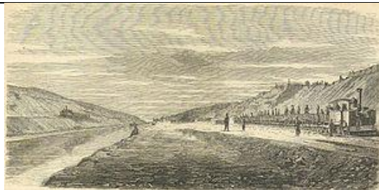
Les travaux du canal de Suez
