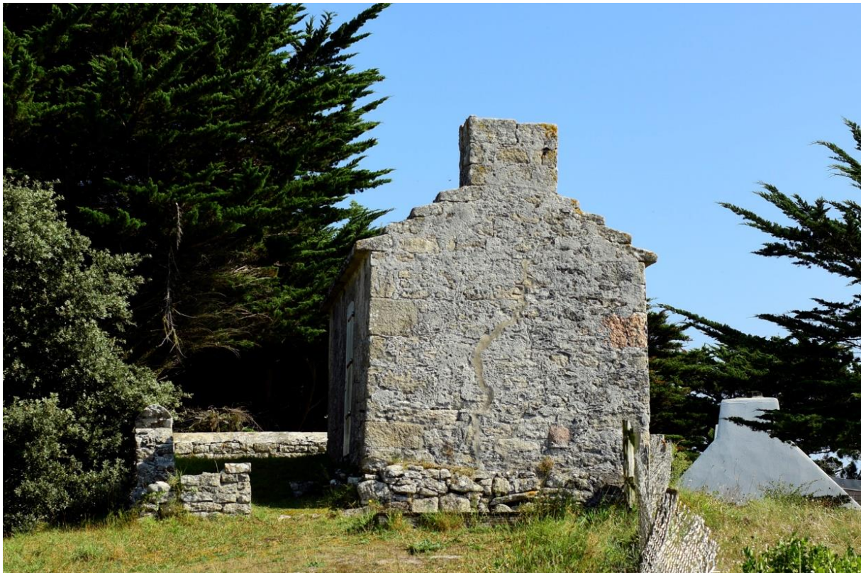
Le poste à signaux de Pich Poud à Loctudy (Photo de Stéphane Brégeon)
